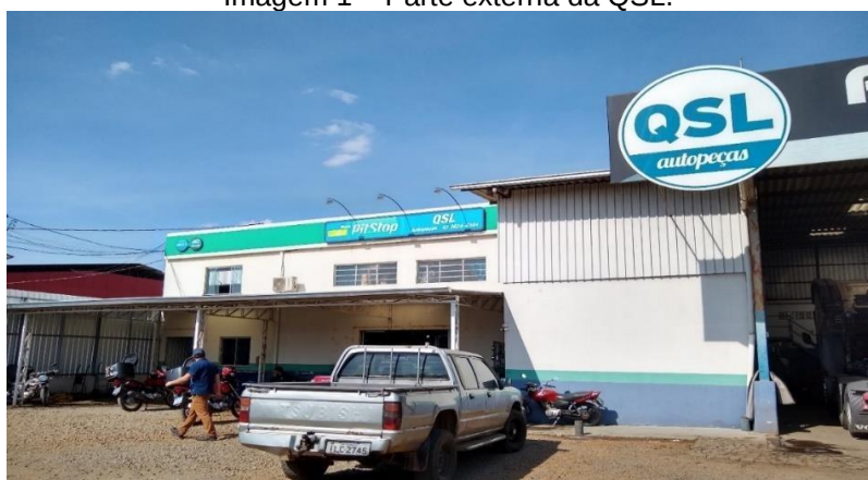
Imagem 1 – Parte externa da QSL.
