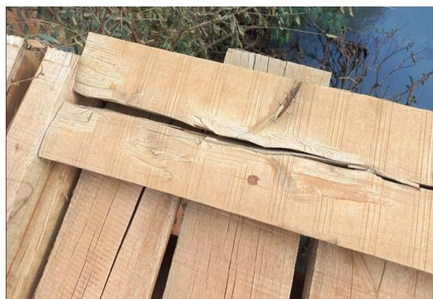
Fissura no assoalho e ausência de chapa de reforço
