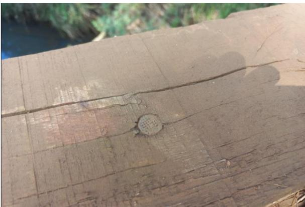
Corrosão da ligação metálica com fissuras
