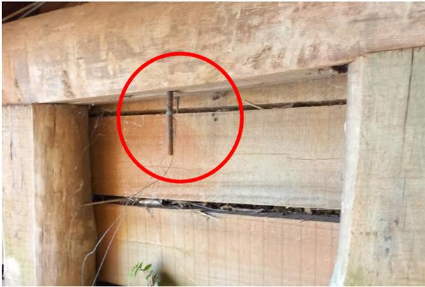
Ligação metálica com corrosão
