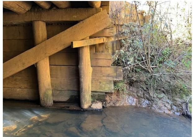
Erosão contida com muro de arrimo
