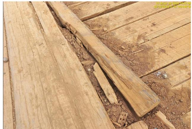
Abrasão mecânica rodeiro com fenda nos componentes
