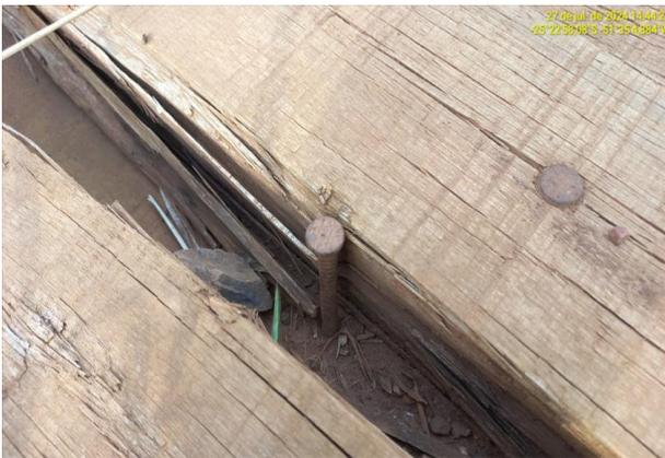
Fenda no assoalho causado pela ligação metálica
