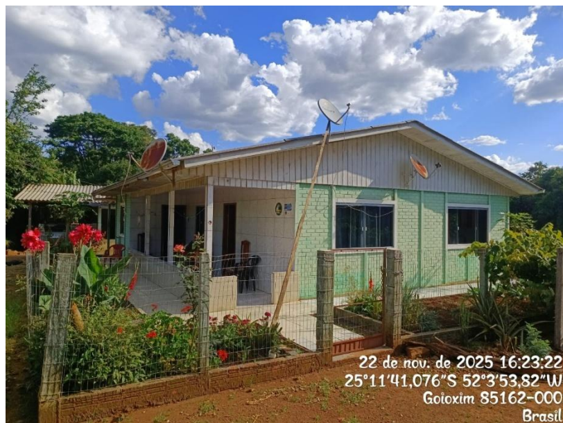
Figura 4 – Vista externa da Edificação 2
