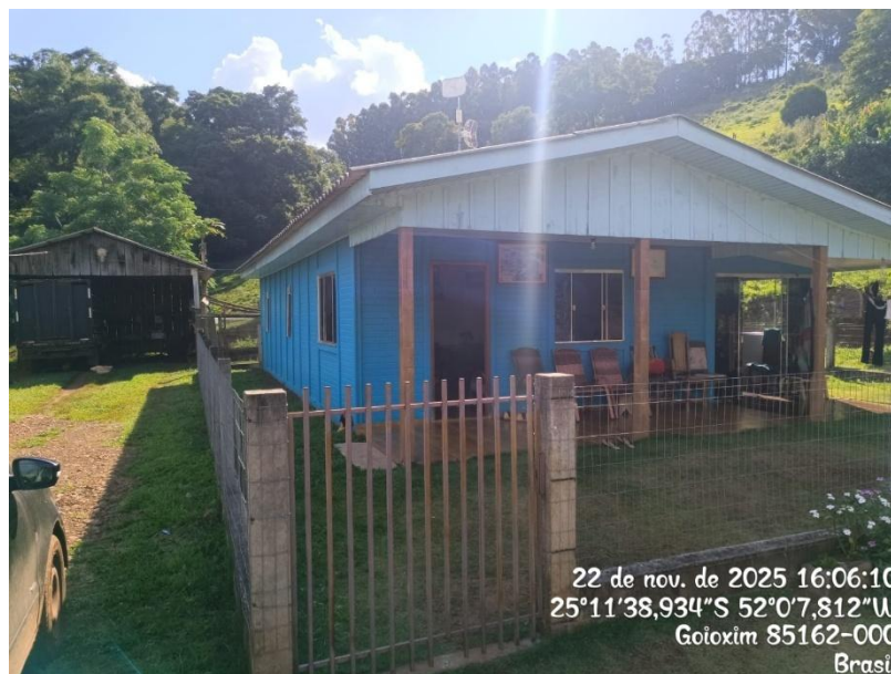
Figura 6 – Vista externa da Edificação 3
