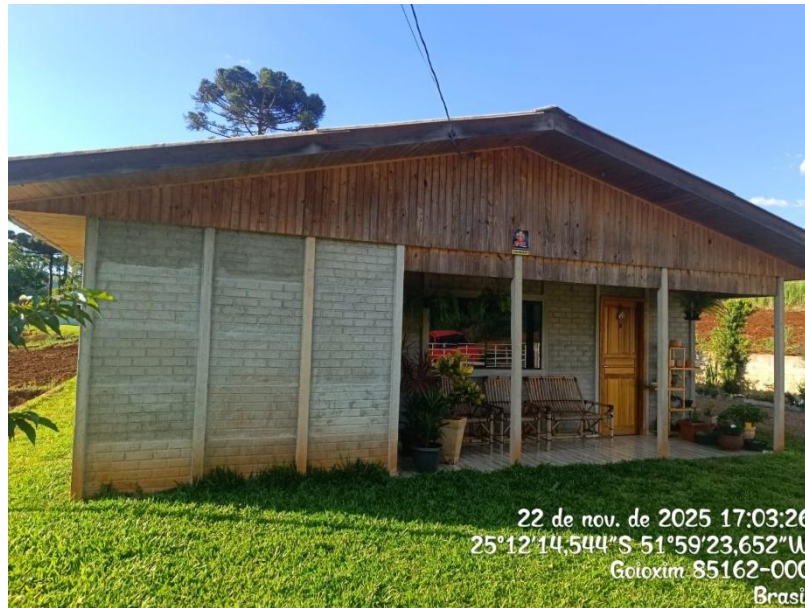
Figura 8 – Vista externa da Edificação 4
