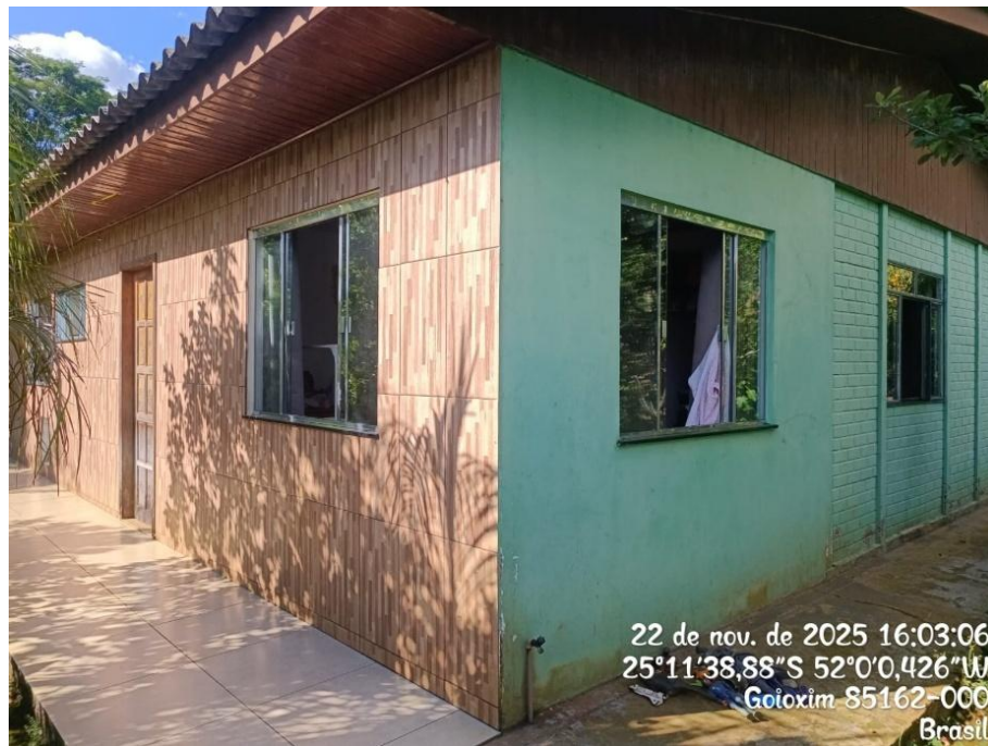
Figura 2 – Vista externa da Edificação 1
