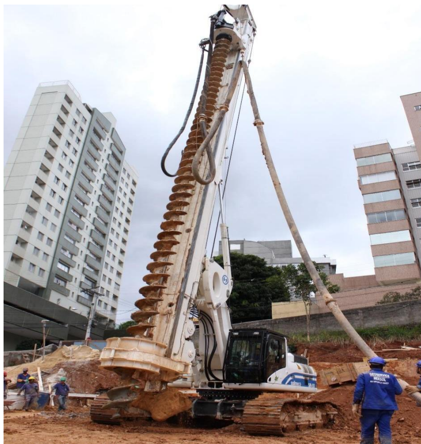
Figura 05 – Equipamento do tipo Hélice Contínua.
