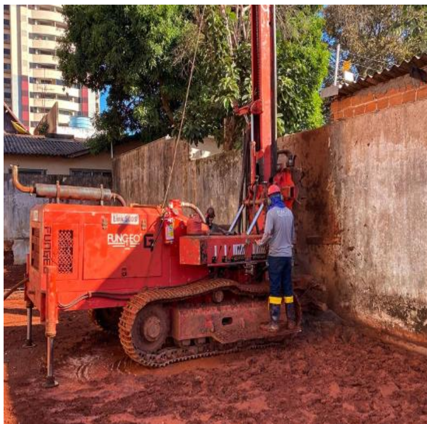
Figura 04 – Equipamento do tipo estaca Raiz.
