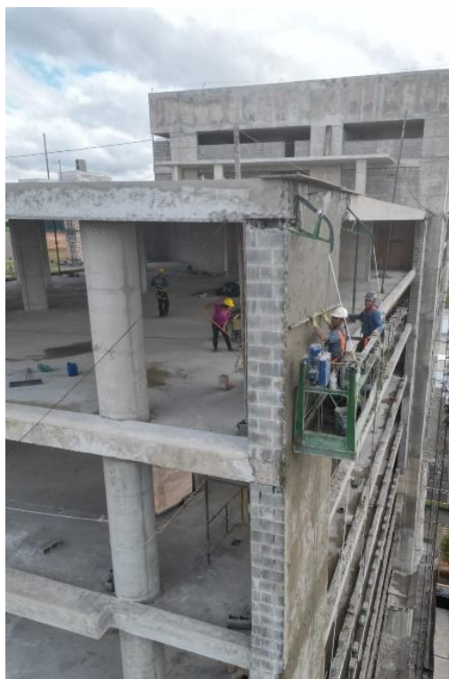
Figura 9 – Inspeção aérea utilizando o drone DJI Mini 3 na prumada 8.
