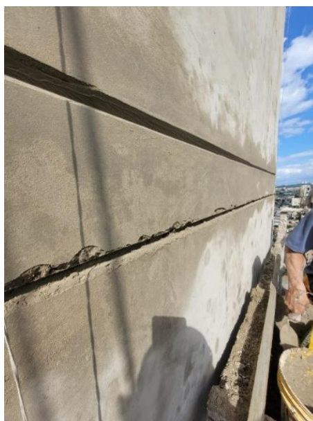
Figura 1 – Acompanhamento em balancim da execução das primeiras juntas de movimentação no reboco da fachada.
