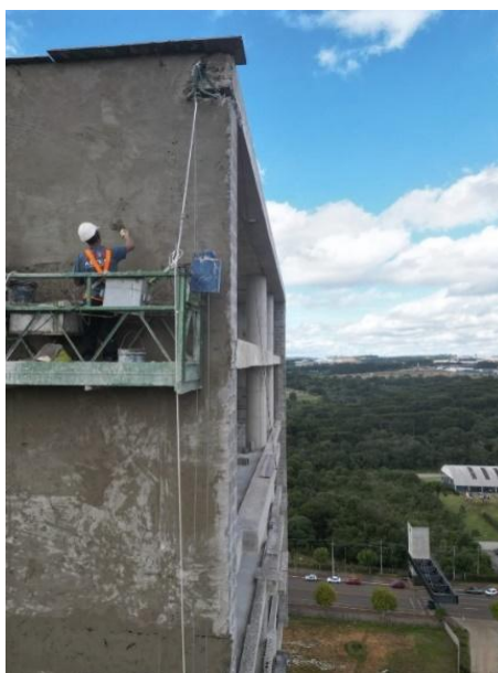
Figura 2 – Acompanhamento via drone da execução da execução do reboco sendo desempenado.
