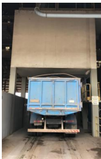
Figura 5 – Caixa de armazenamento de impurezas
