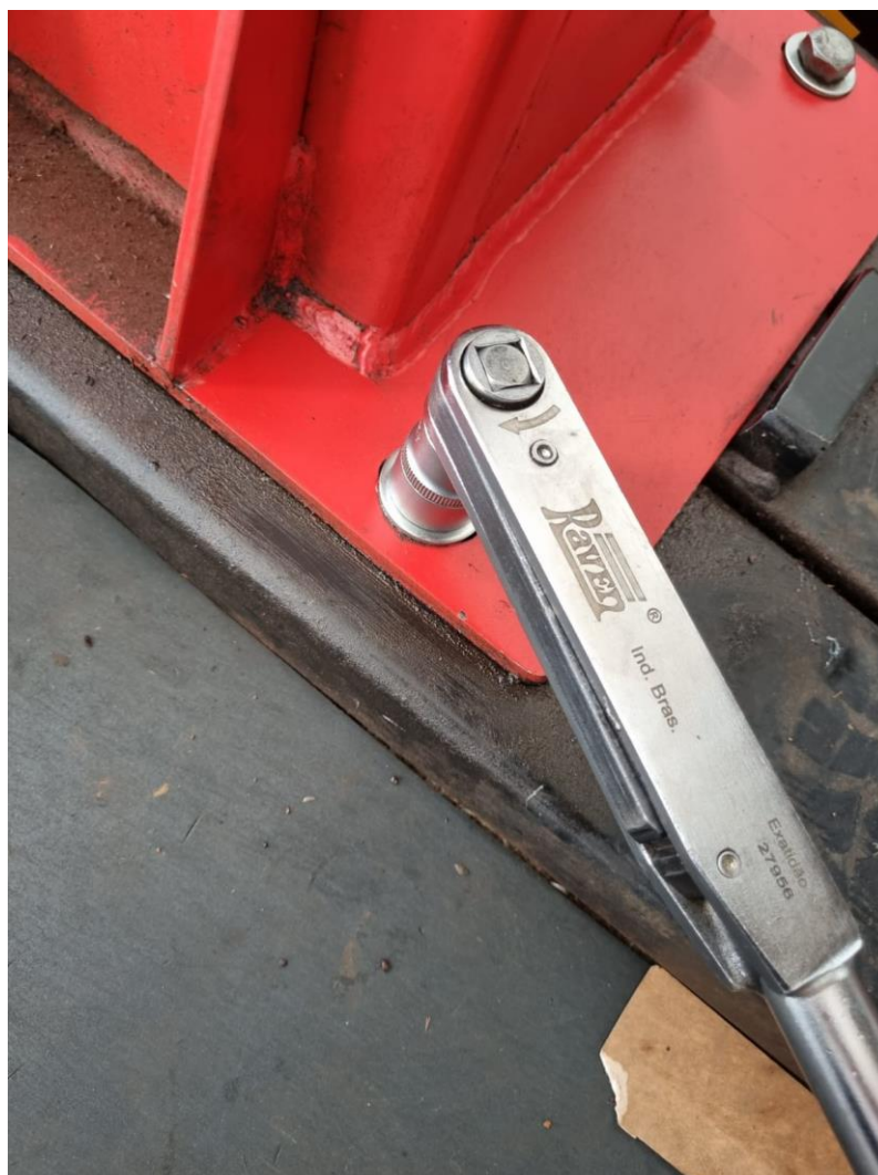
Figura 6 – Ajuste de torque nos parafusos de fixação.
