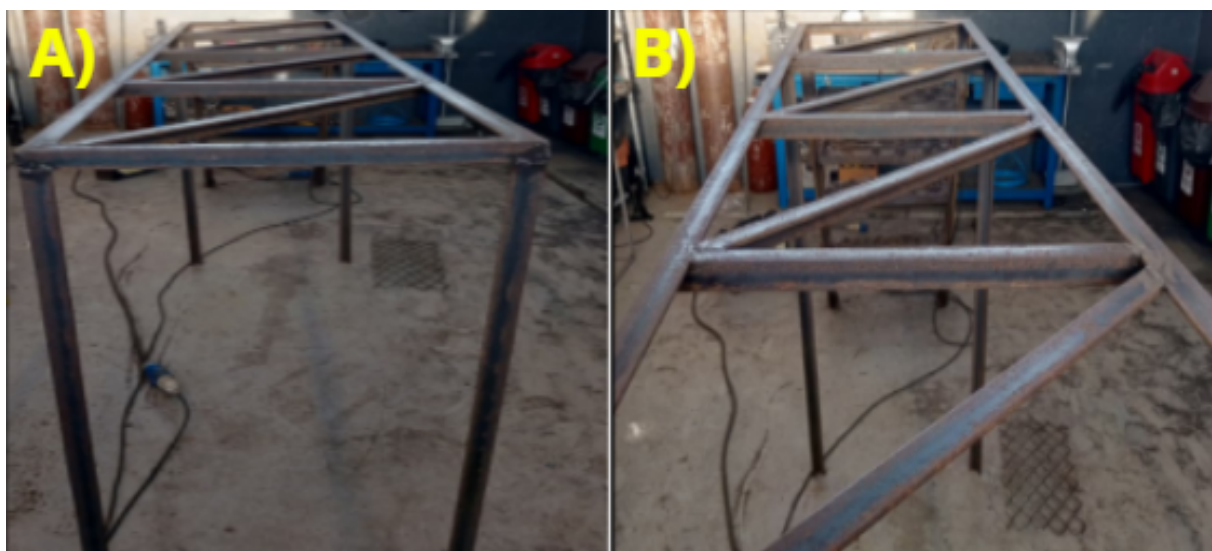
Figura 8 – Processo de Fabricação; (A) Foto Frontal. (B) Base Passarela.
