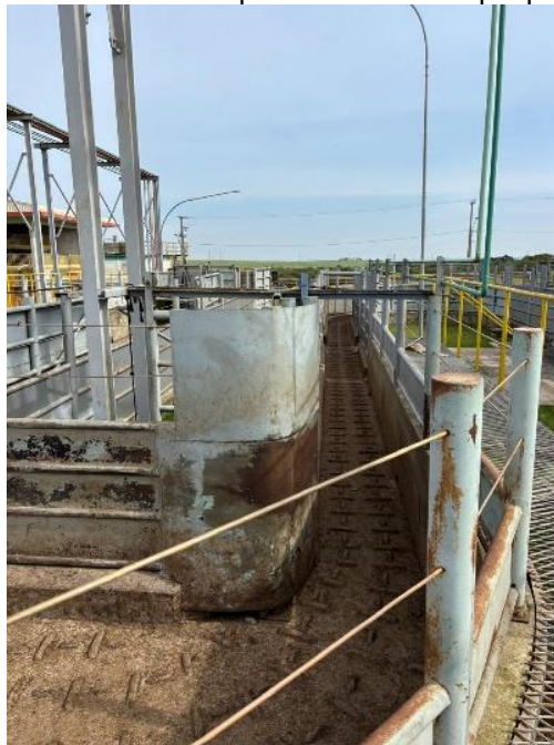
Figura 8. Corredor para o curral antiderrapante sem locais que possam causar ferimentos.
