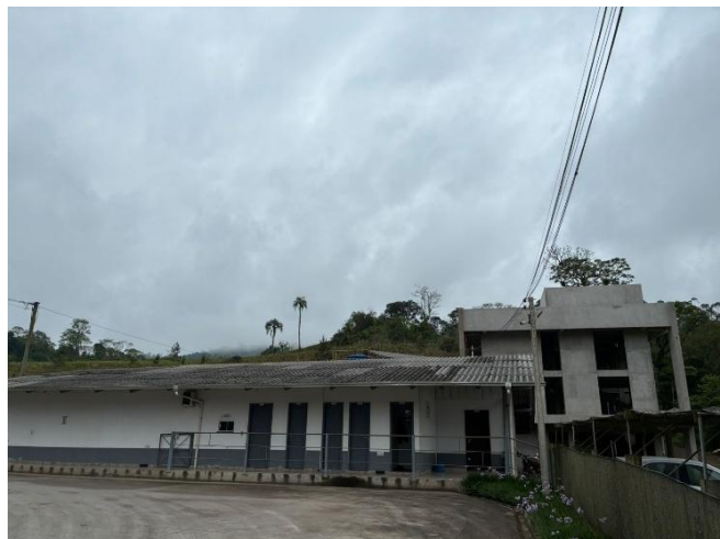
Figura 3B. Escritório em construção
