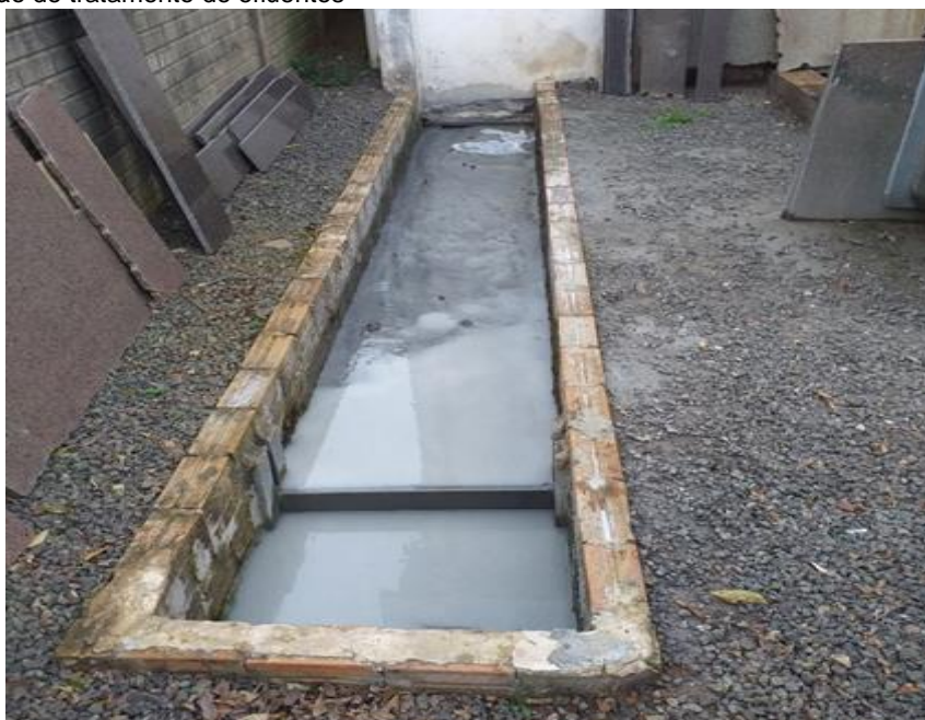
Figura 3 - Estação de tratamento de efluentes
